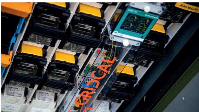
Die GridCal-Nodes (hier als Digitalleiste) lassen sich unkompliziert auch in Bestandsanlagen einbauen und sind in wenigen Minuten einsatzbereit. (Foto: PSInsight GmbH)
